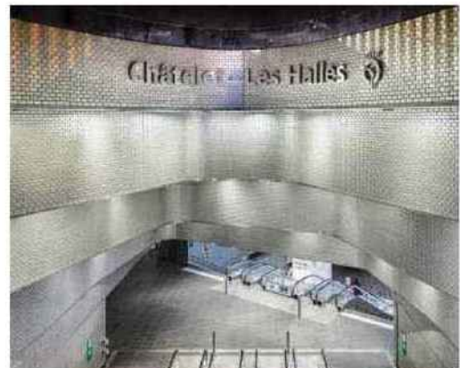
Revêtu de carreaux Métro en verre et chrome, conçus par La Rochère en collaboration avec le cabinet d'architectes Patrick Berger et Jacques Anziutti, la station de Châtelet-Les Halles s'est métamorphosée.
