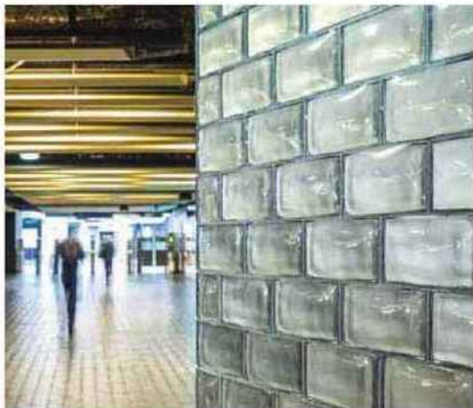
Le carreau Métro de La Rochère est une pièce de verre coulée et pressée. Dans le fond, une couche de polyuréthane colorée à base de pigments de chrome et protégée par une seconde couche d'époxy donne la couleur au carreau.
